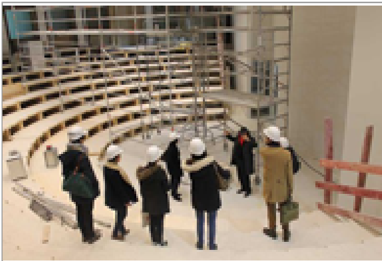
Visite inédite du chantier pour des étudiants de l'ICP
